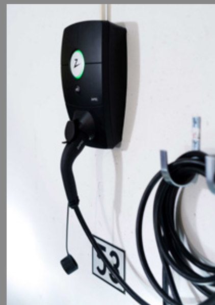
Seit 2020 wurden europaweit rund 120'000 Zaptec-Ladestationen montiert.
